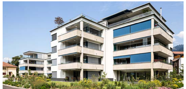
Fertig erstellte Mehrfamilienhäuser mit 20 Wohneinheiten.
