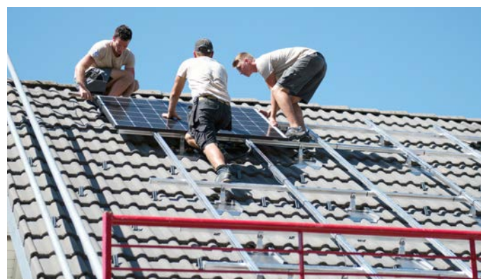
Montage einer Solaranlage in Schänis
