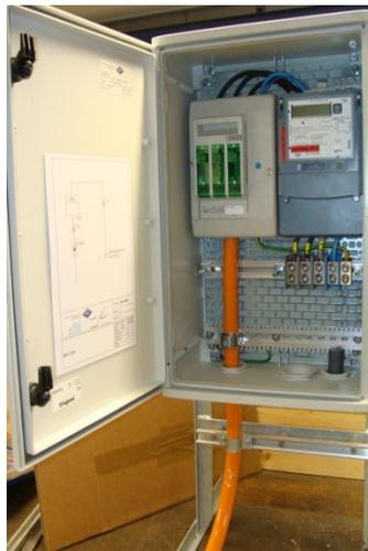
Das Anschlusskabel des Baustromverteilers wird durch eine Kabelverschraubung in den Bauanschlusskasten eingeführt und an den Woerz-Klemmen angeschlossen.
